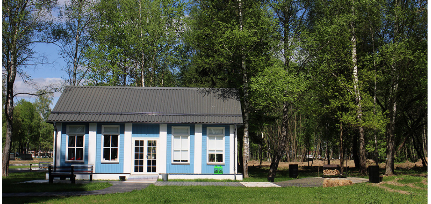
Общий вид павильона
