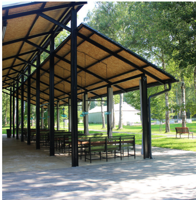
Вид холла от бара
